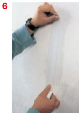
**7. Maintenir la bande à fissures en place avec un couteau de peintre et l'appliquer contre l'enduit avec un autre couteau.**
