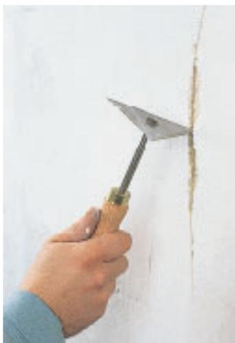
**1. Élargir la fissure avec un grattoir triangulaire afin de bien la garnir de reboucheur; c'est ce que les professionnels appellent "ouvrir" la fissure. Gratter énergiquement.**
