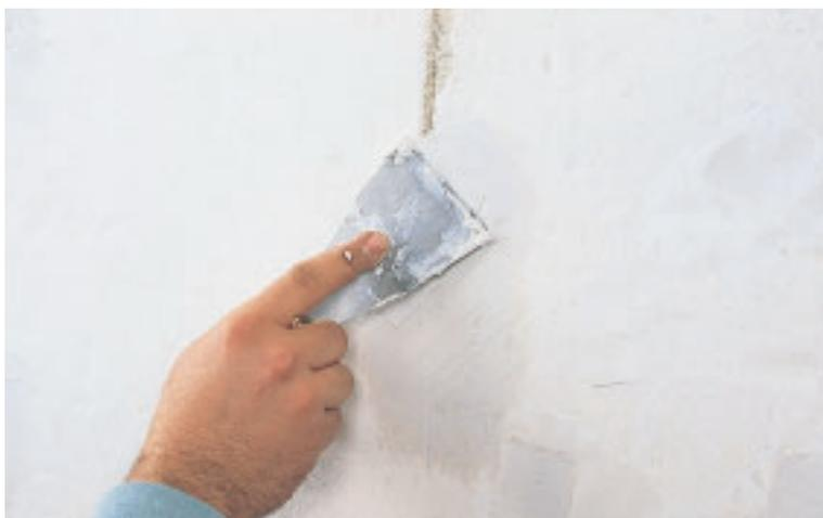
**6. Appliquer un morceau de bande à fissures sur l'enduit qui vient d'être lissé.**
