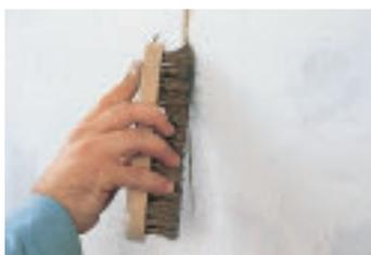
**2. Avec une brosse métallique en fils de laiton, éliminer toutes les particules qui tiennent mal. Il faut que les bords de la fissure soient solides pour que le reboucheur accroche bien.**
